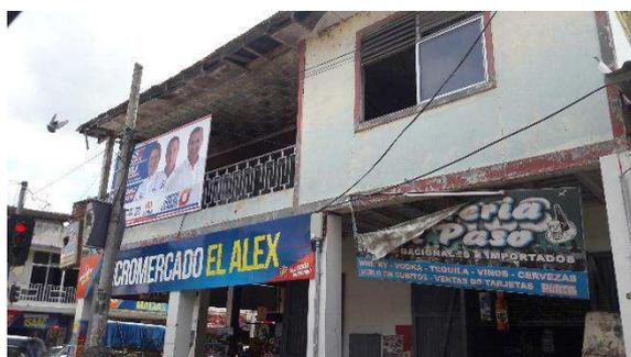
Imagen#24 – Vivienda estructura de hormigón con piso de madera y cubierta metálica
