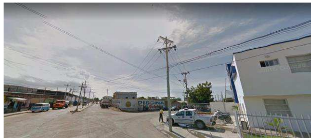
Figura N°42: Visualización de Red Eléctrica Fuente: Investigación de campo
