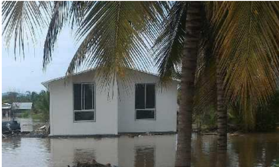
Grafico 32: Viviendas reconstruidas por el MIDUVI después del Terremoto del 16 de abril del 2016 en el sitio Puerto Loor.
