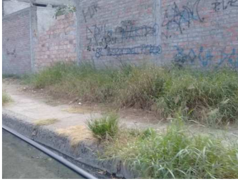
Imagen 2: Acera intransitable por arbustos en mal estado. Fuente: Marjorie Santos.
