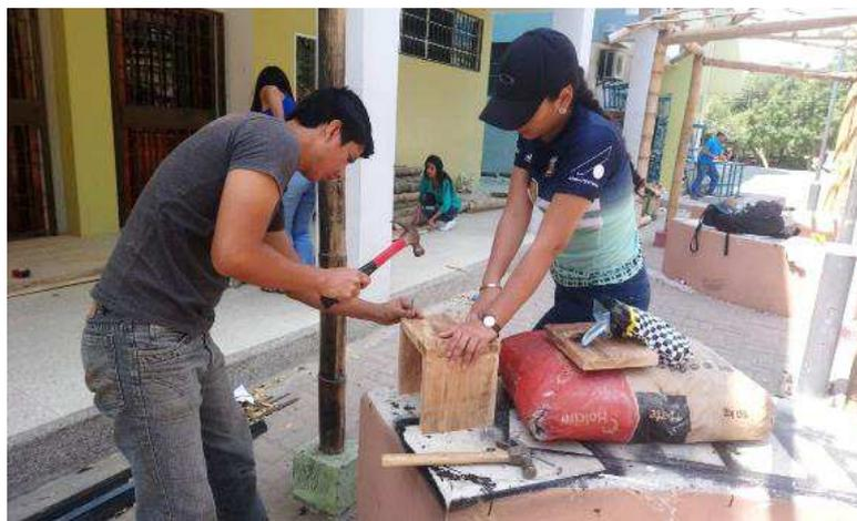
*Figura 40:* Armado de encofrado.
