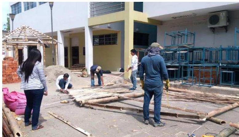
*Figura 38:* Colocación de latillas en fachadas.
