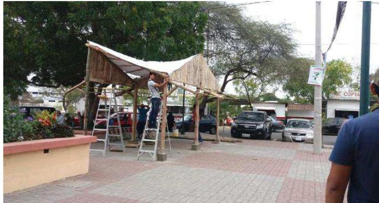
*Figura 44:* Colocación de lona central.
