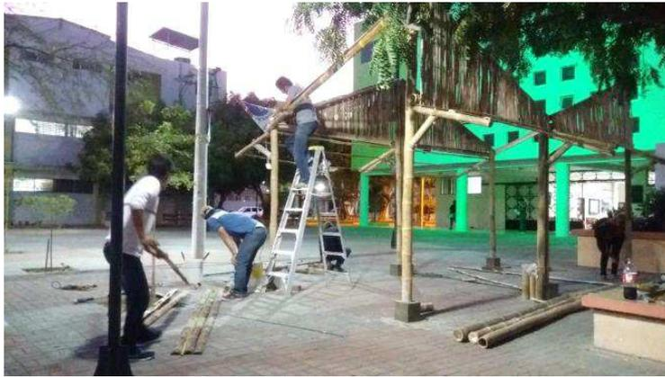
*Figura 43:* Colocación de correas para cubierta de lona.
