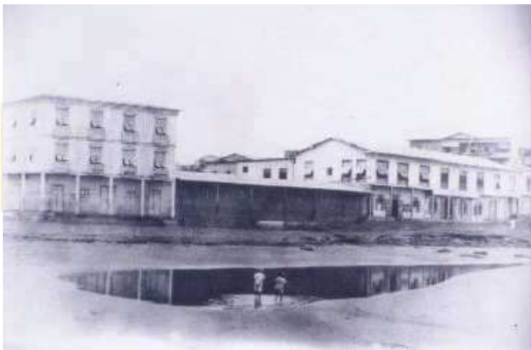
Fotografía 1: En la esquina la primera casa-hotel de Manta (Actual Banco del Austro).
