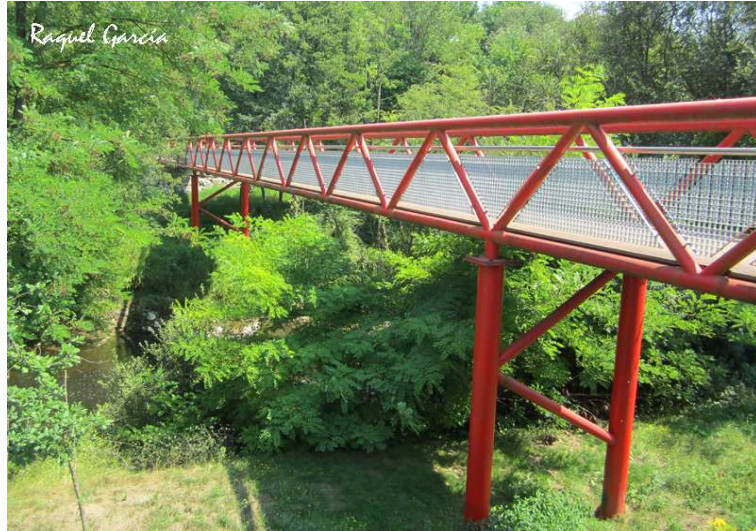
Ilustración #12: Vista Puentes Elevados Fuente: Turismo Vasco Año 1998
