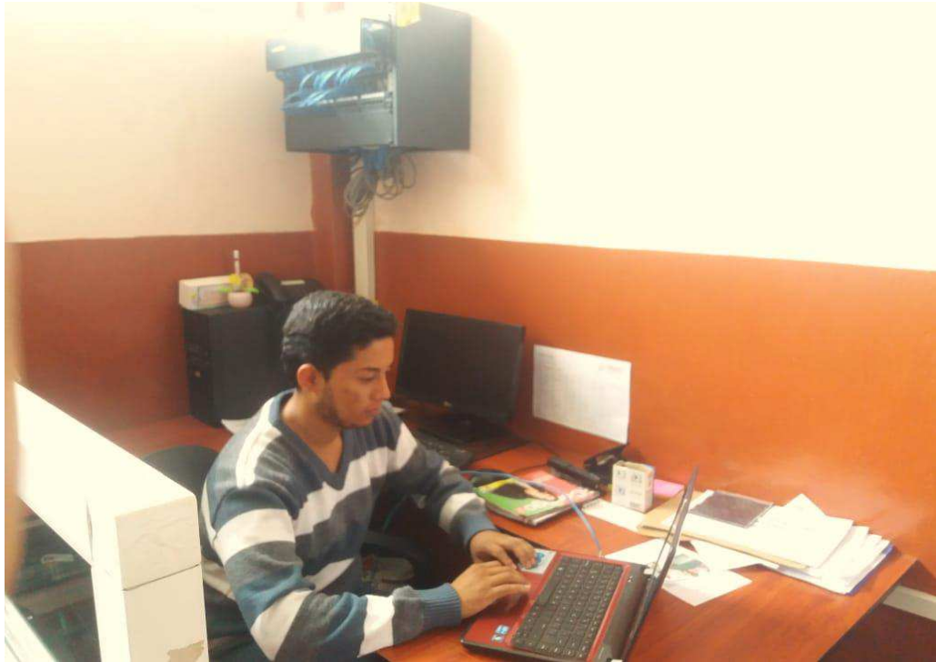
Anexo 10: Realizando el análisis a los puntos de conexión del Switch R7 (Sala de profesores 2).
