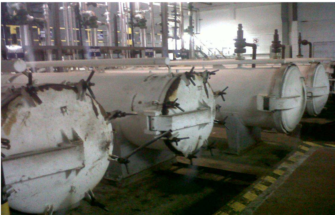
Fotografía # 8.6.- área de esterilización de latas del proceso productivo FUENTE: Autores de tesis
