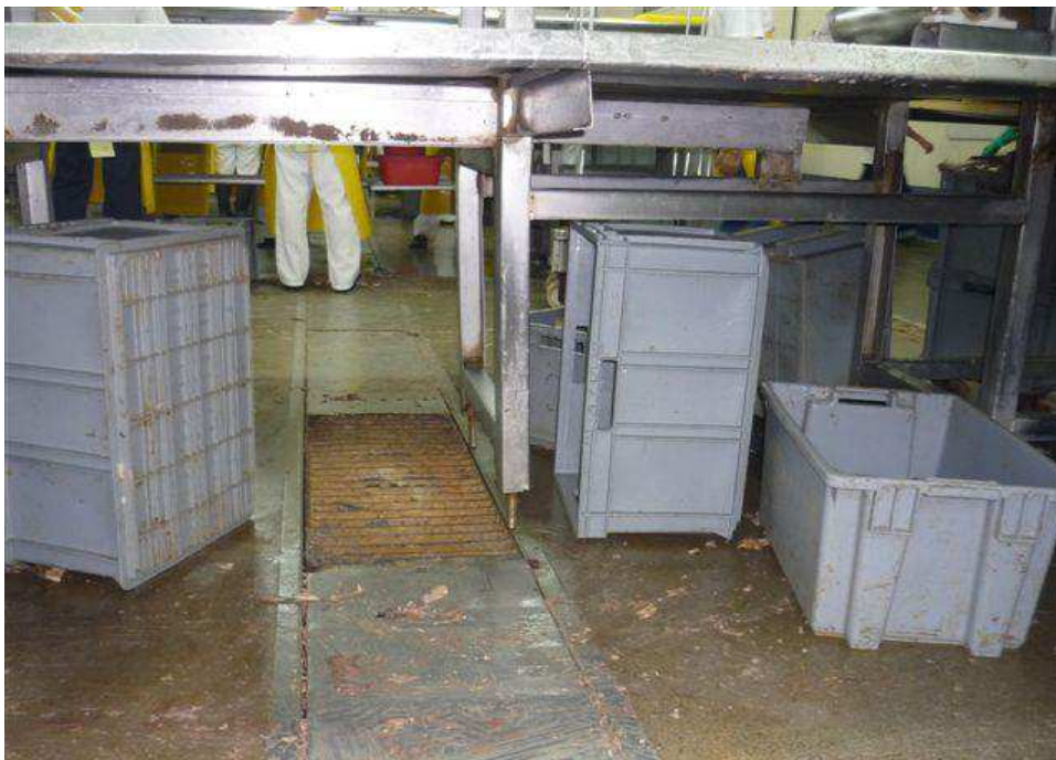
Fotografía # 3.- Piso con residuos y acumulación de gavetas.
