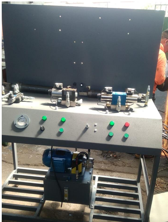
Figura 36. Proceso de montaje de equipos
