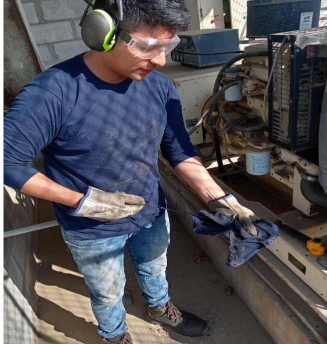
Anexo 9. Limpieza de bayoneta del equipo
