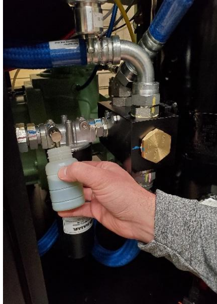
Figura 6. Toma de muestra de compresor
