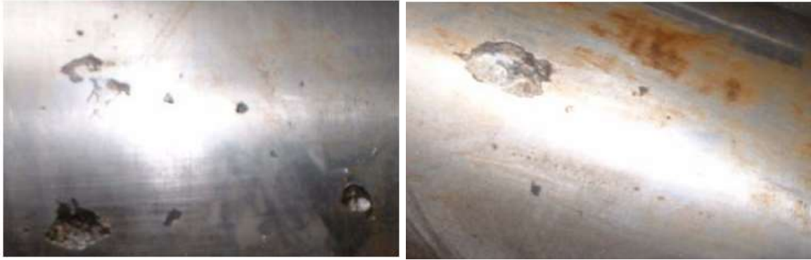
Figura 4. Fenómenos de picaduras del actual sistema de eje barco de 35 toneladas Fuente: Elaboración propia
