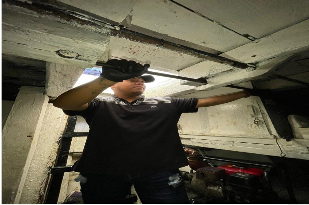
Mantenimiento a la cañería de los gatos hidráulico de popa.
