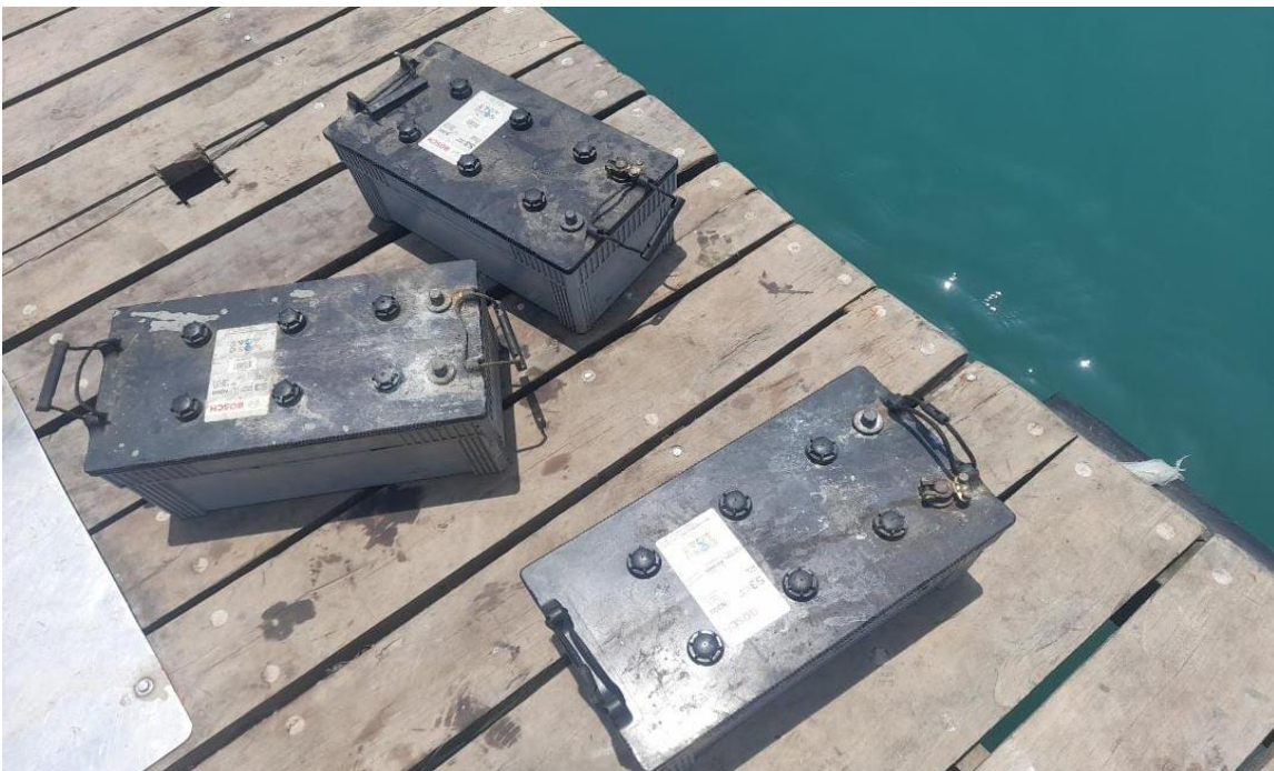
Retiro de baterías en mal estado
