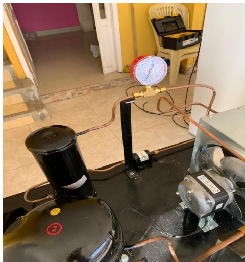
Figura 34 Colocación de manómetros
