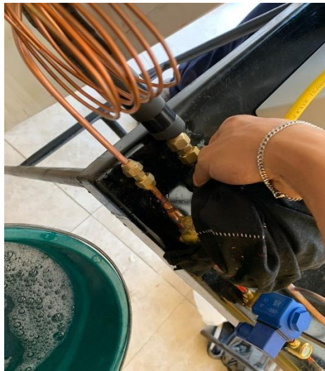
Figura 37 Verificación de fugas en cañerías
