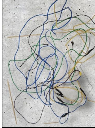
Figura 27. Parte del cableado retirado (motor-teensy / encoder-teensy)
