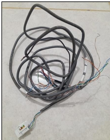
Figura 28. Parte del cableado retirado (final carrera-teensy)
