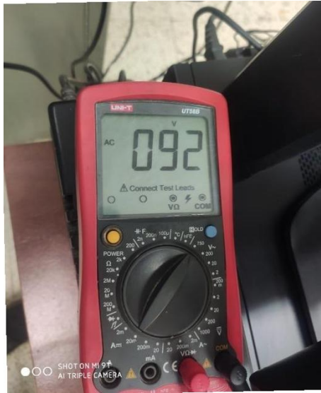
Anexo 2. Medición del voltaje
