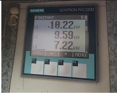
En cuanto a los kilovatios (kW), las mediciones fueron las siguientes: para la línea 1 (L1) se midieron 10.22 kW, para la línea 2 (L2) 9.59 kW, y para la línea 3 (L3) 7.22 kW. Estas diferencias también indican un desbalance en la carga de potencia activa entre las líneas.
