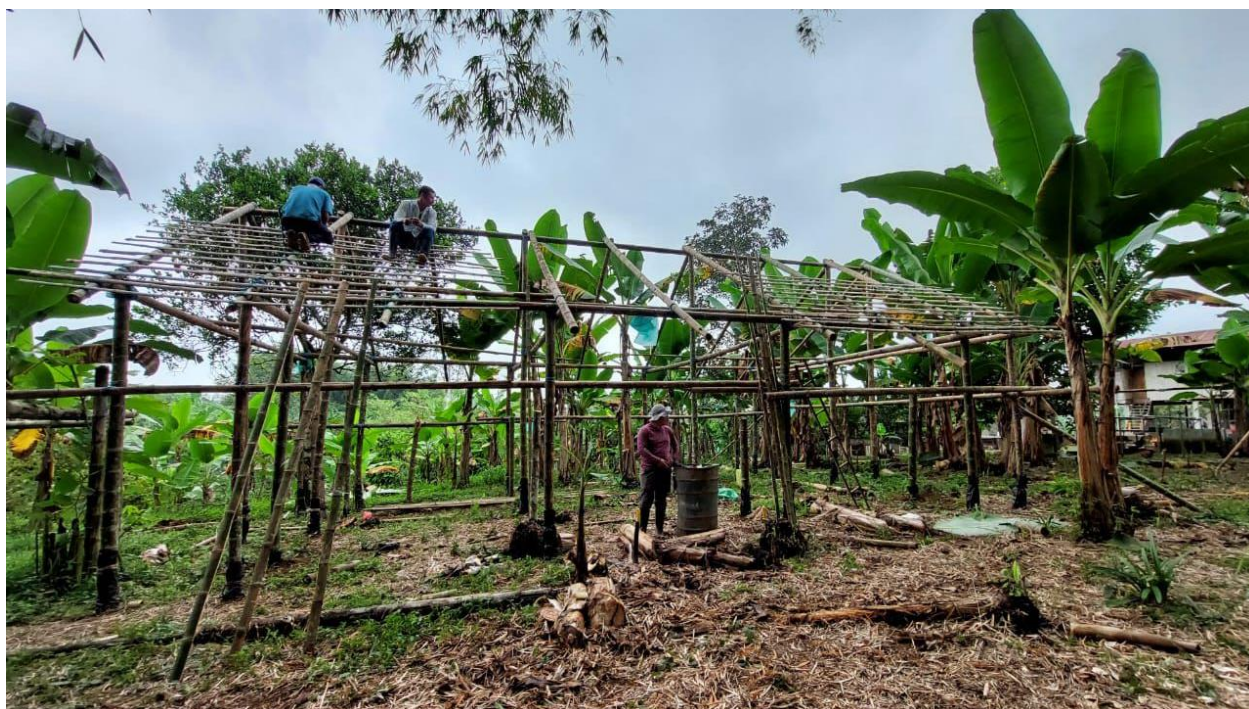
Anexo 15. Construcción del galpón ecológico.
