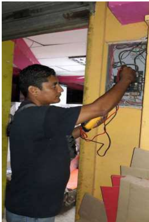
Imagen 5.- Medición de voltaje del Edificio “Ligia Elena”
