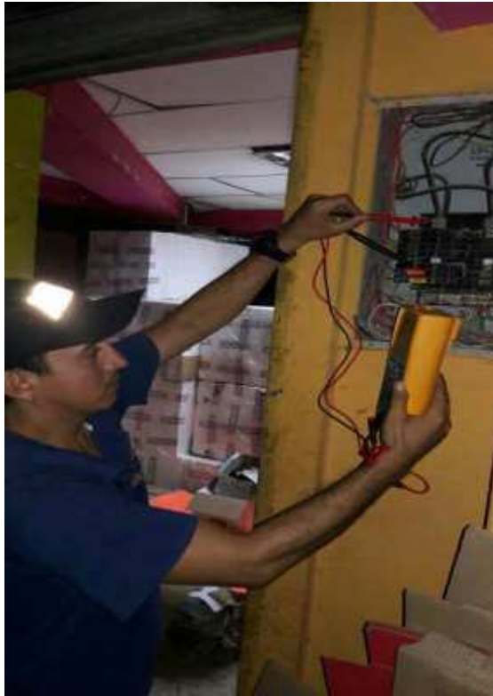
Imagen 5.- Comprobación de resistencia y amperaje del Edificio “Ligia Elena”
