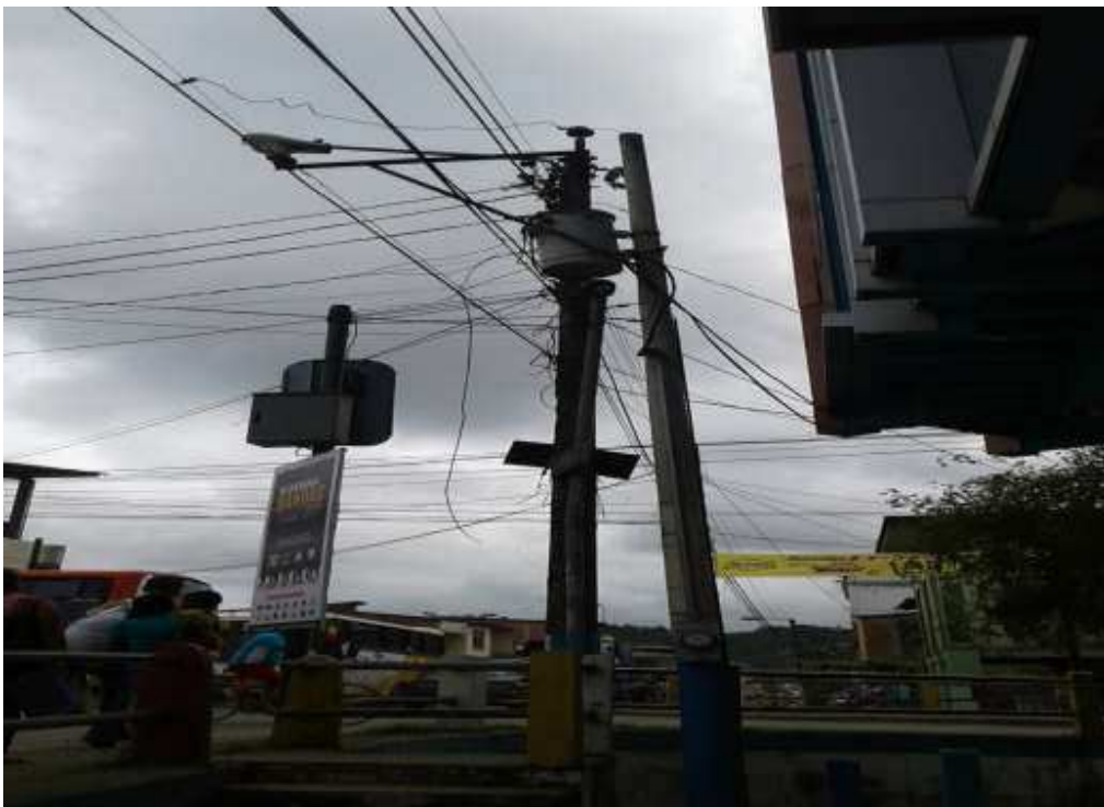
Imagen 6.- Transformador del Edificio “Ligia Elena”
