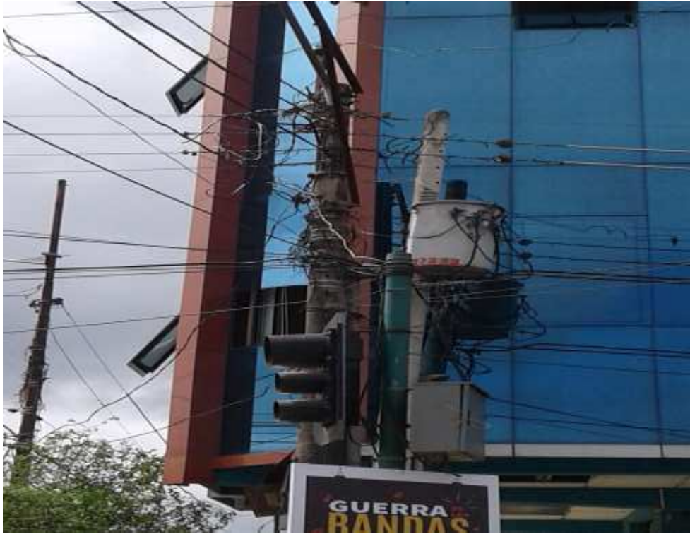
Imagen 6.- Transformador del Edificio “Ligia Elena”
