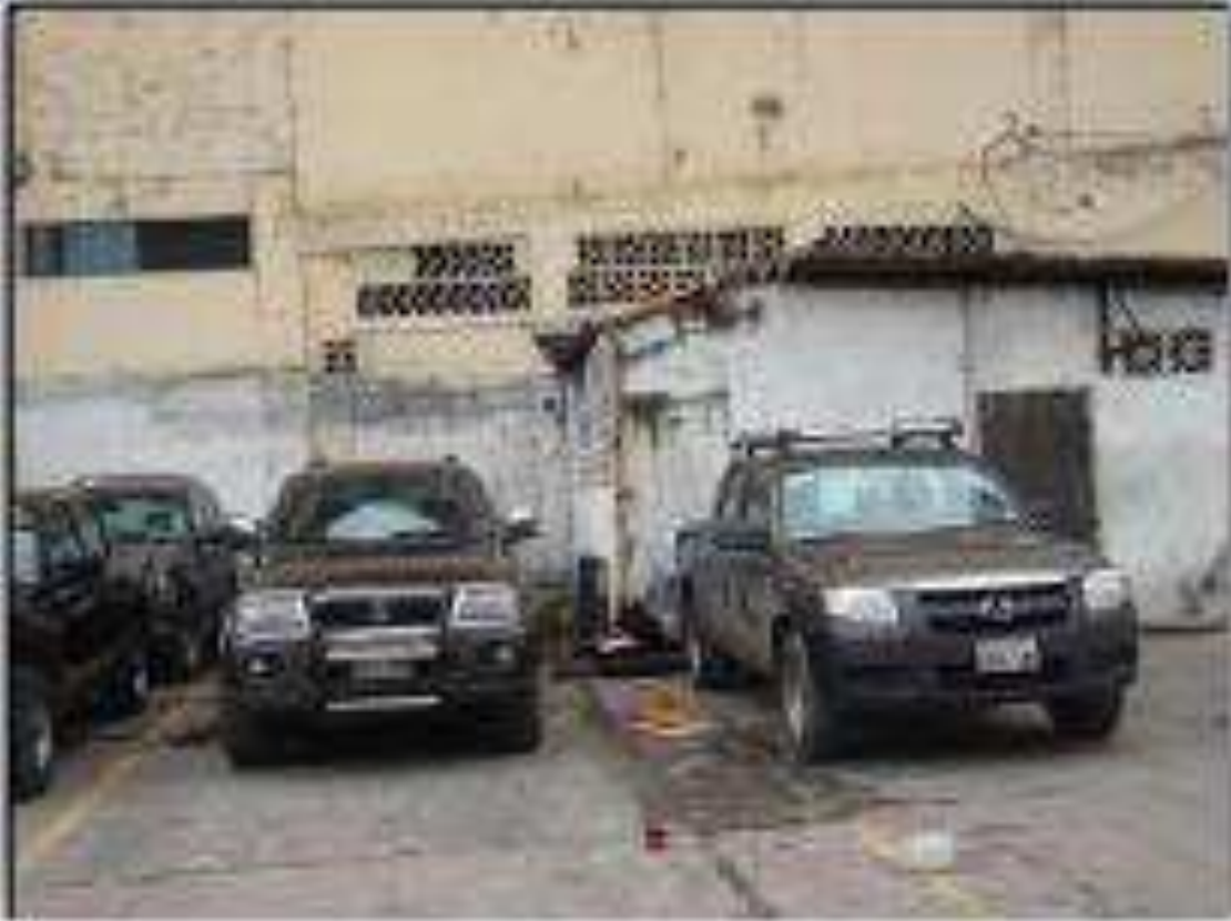
Figura 24: Lugar de ubicación de la varilla a tierra
