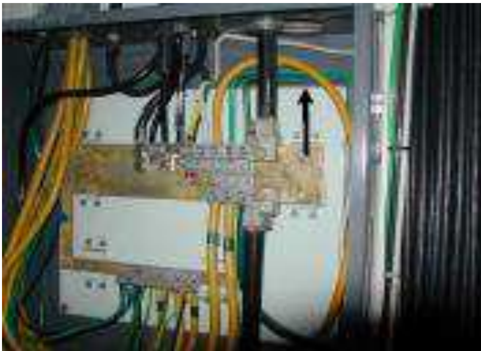
Figura 32: Barra de tierra principal del tercer piso
