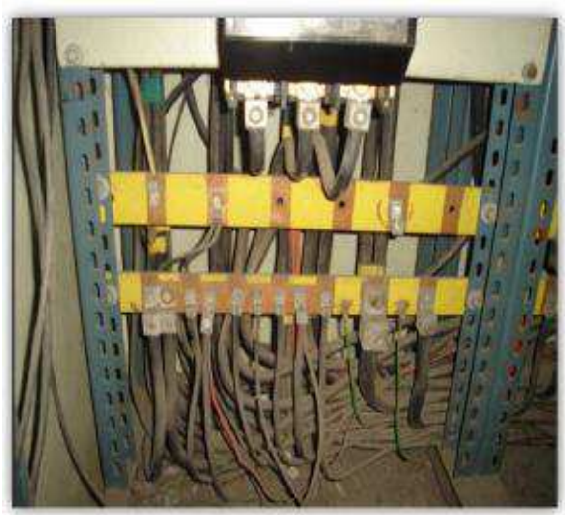
Figura 20: Neutros y Tierras del tablero de distribución principal
