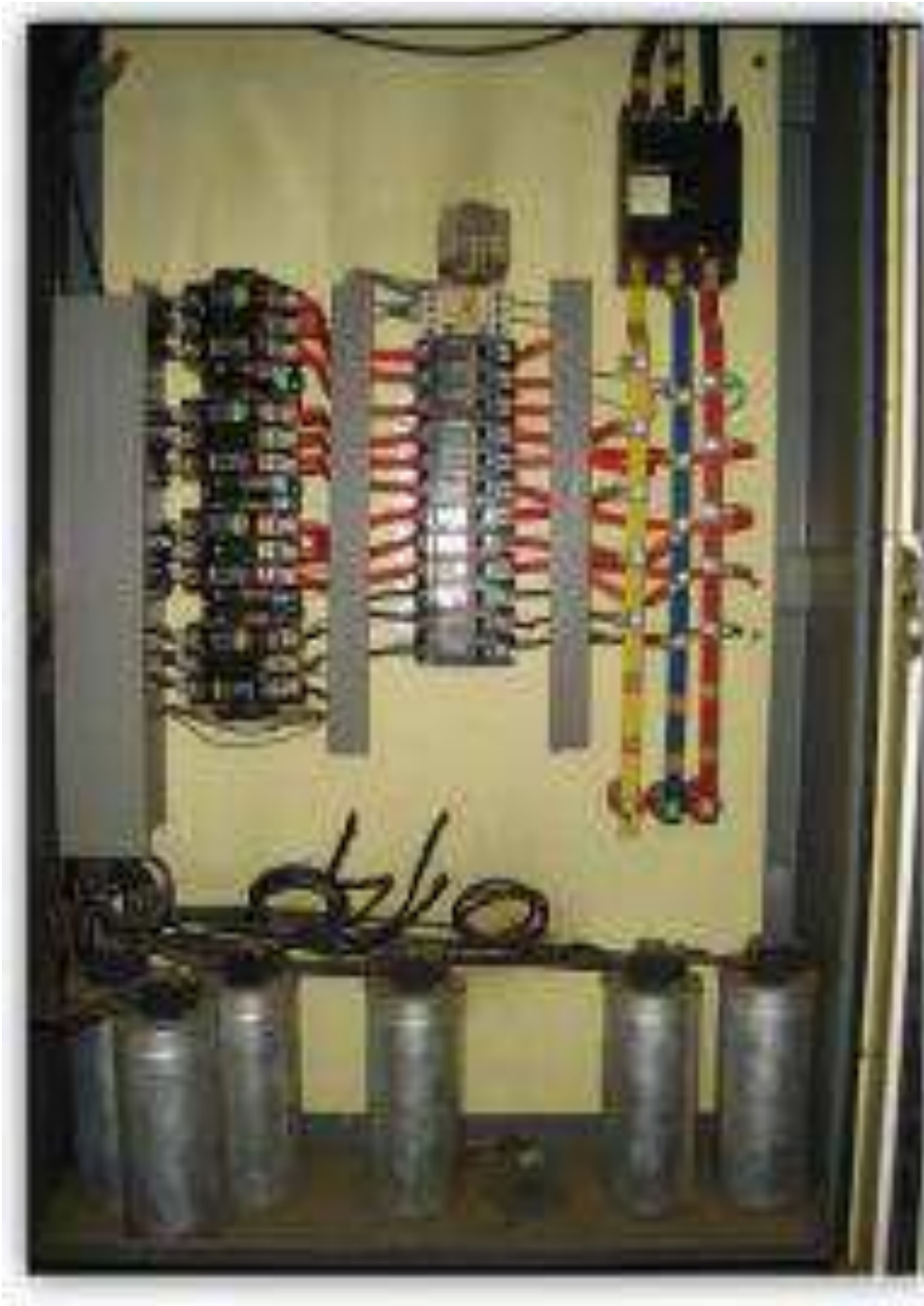
Figura 21: Tablero de condensadores deshabilitado
