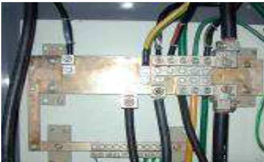
Figura 28: Barra de tierra principal
