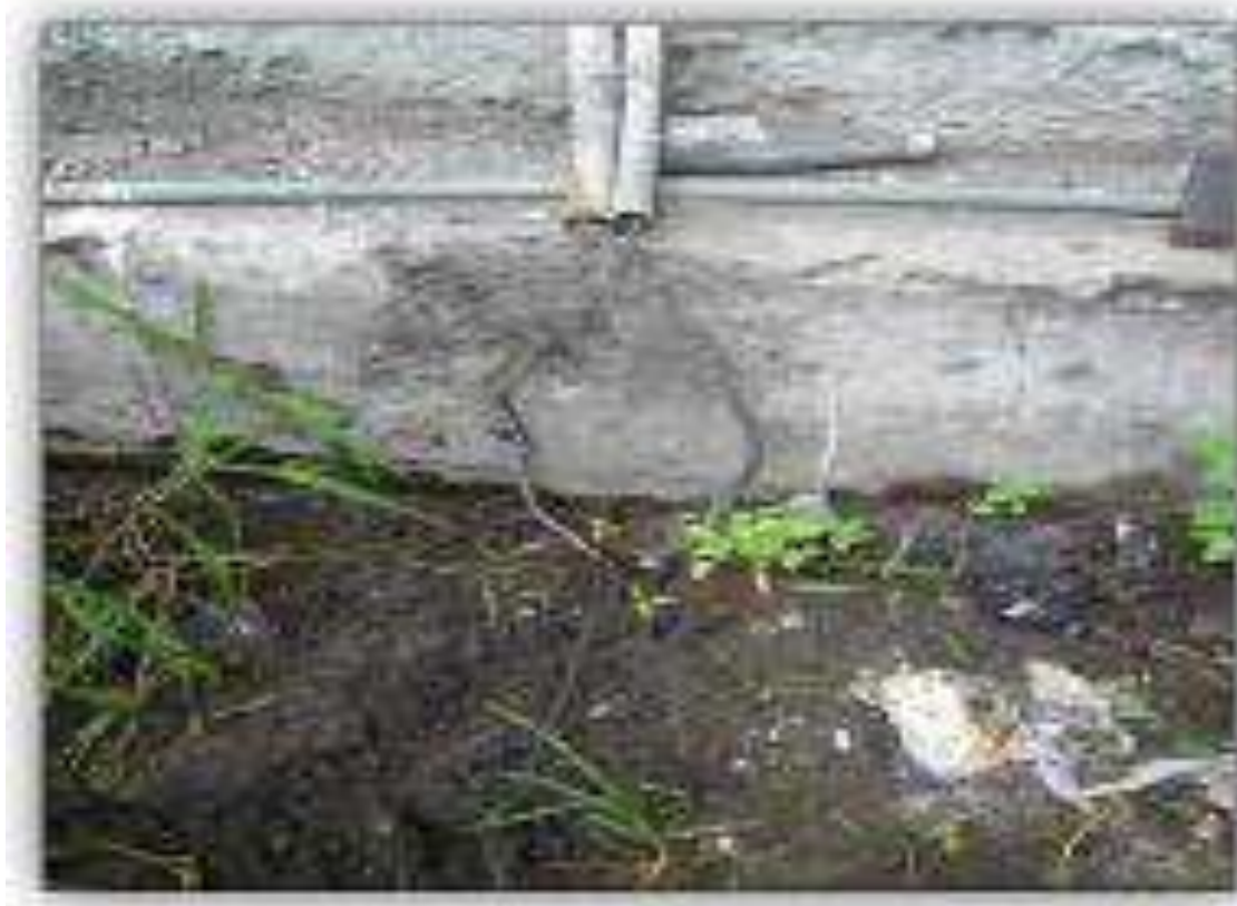
Figura 25: Actual sistema de puesta a Tierra
