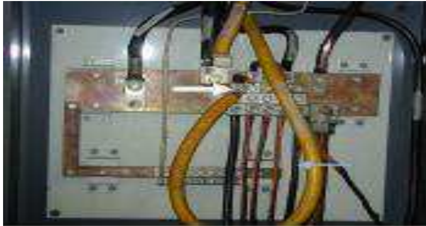
Figura 31: Barra de tierra principal en la Empresa
