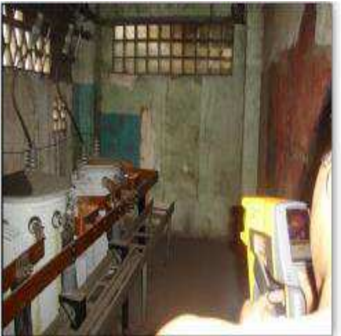
Figura 22: Toma Termografías del banco de transformadores
