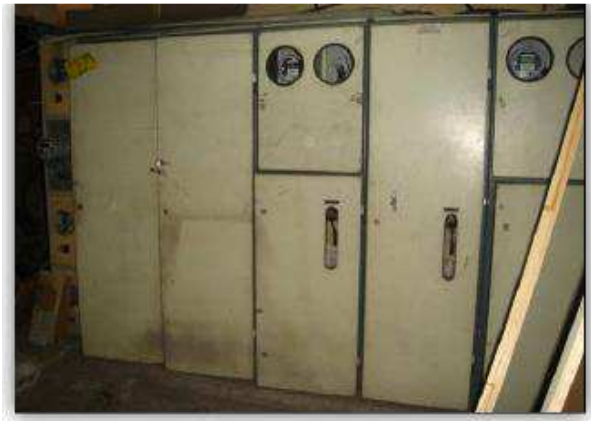
Figura 19: Tableros de Distribución Principal
