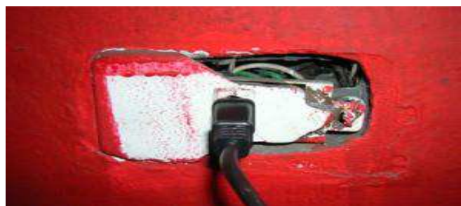
Toma corriente deteriorado.
