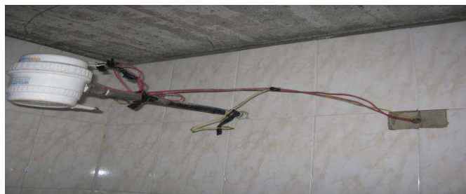
Ducha eléctrica sin conexión a tierra.
