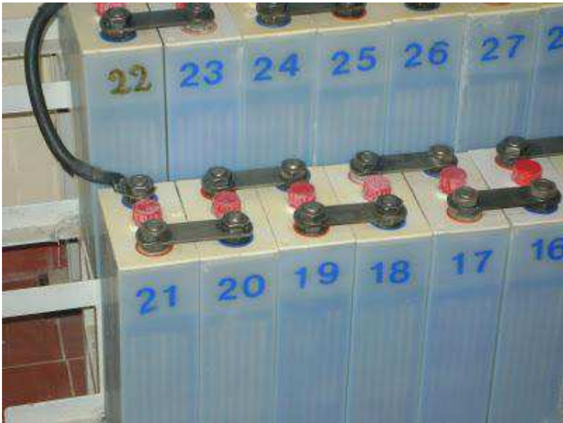
Figura 6: Conexión en Serie, aspecto real.
