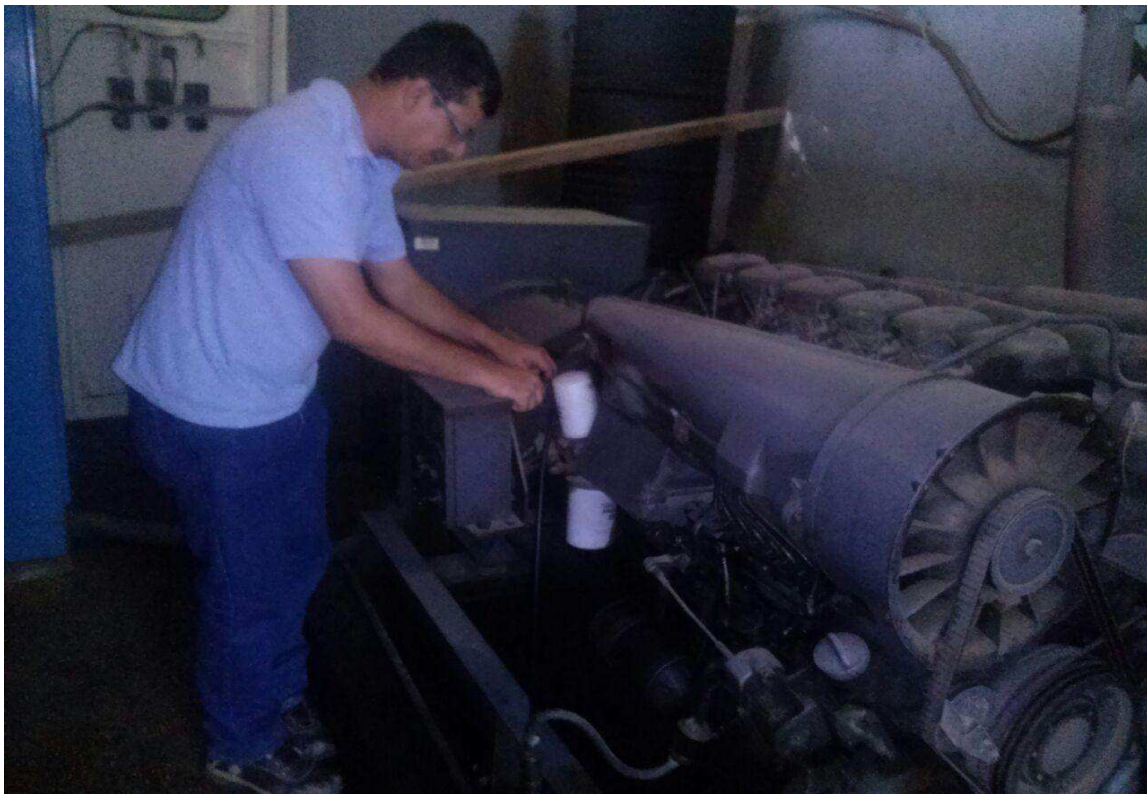
Los investigadores realizando el diagnostico en el Cuarto del Banco de Baterías de la Empresa TeleAlfacom Cía. Ltda.
