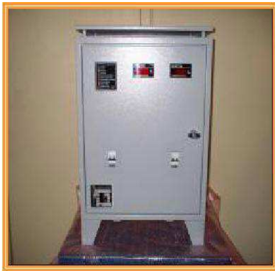
Figura 12: Cargador –Rectificador de Batería.
