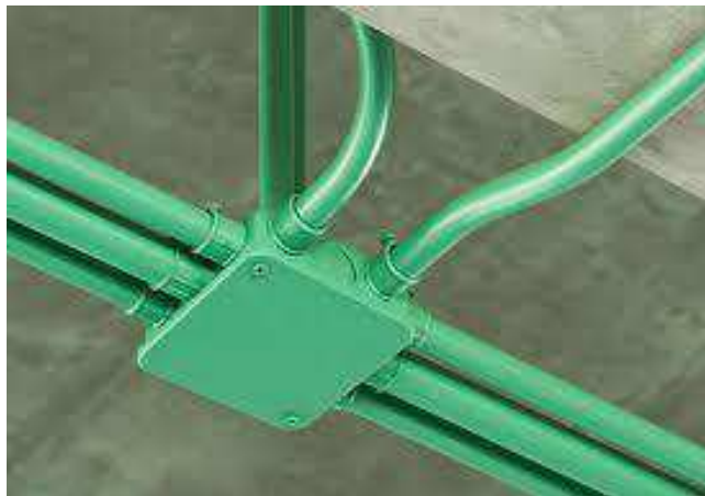
Figura 10: Tubos de conduit metalicos
