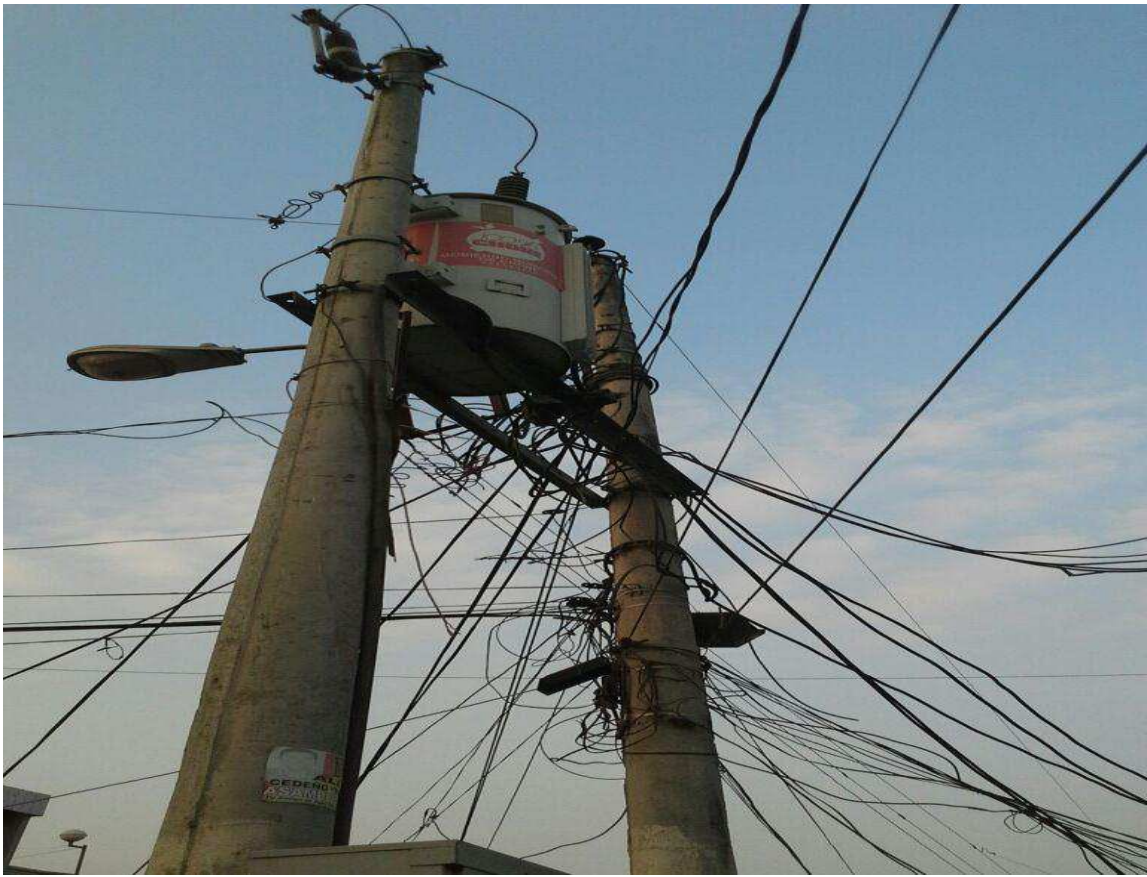
Transformador en redes de distribución 13.8kw grd/7 9.8kv-13.2kv grd/ 7.62kv (TRT-1C1)
