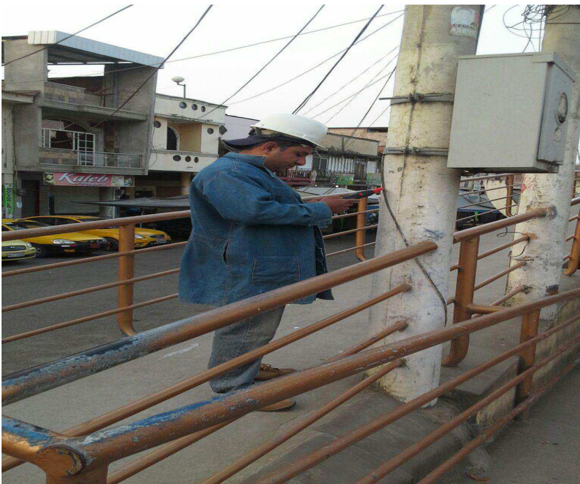
Revisión de caja de derivación
