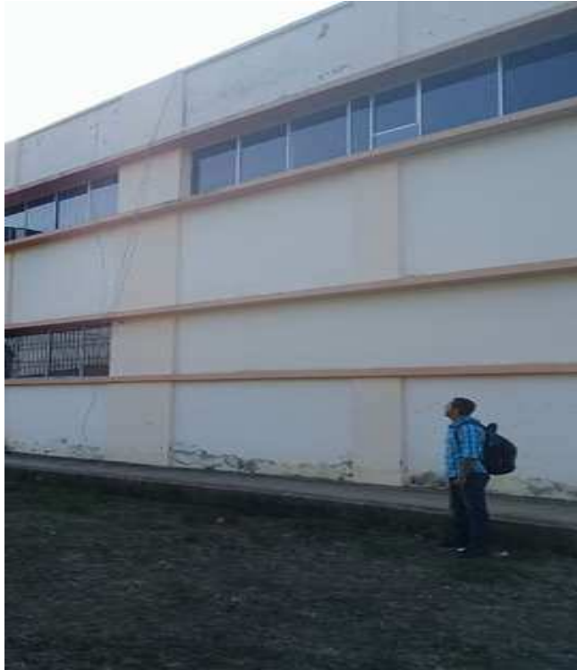
Fuente: medición del subterráneo del líneas de media y baja tensión
