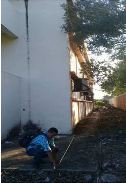
Fuente: medición del subterráneo del líneas de media y baja tensión
