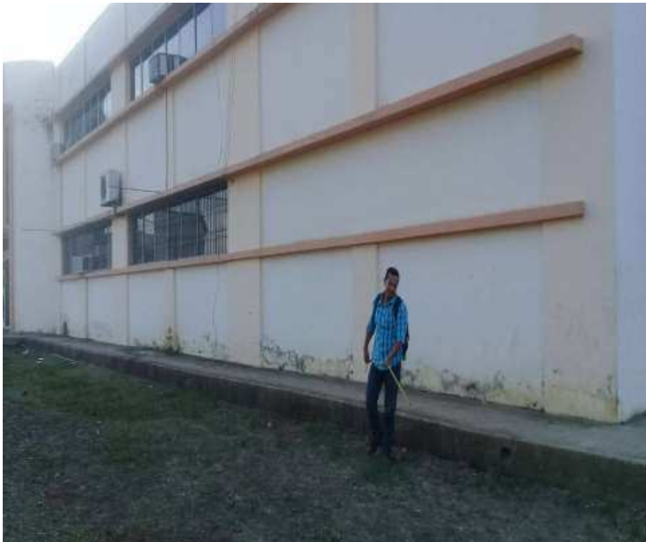
Fuente: medición del subterráneo del líneas de media y baja tensión
