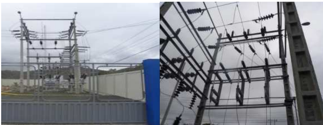
Figura 136. Subestación Puerto Cayo
