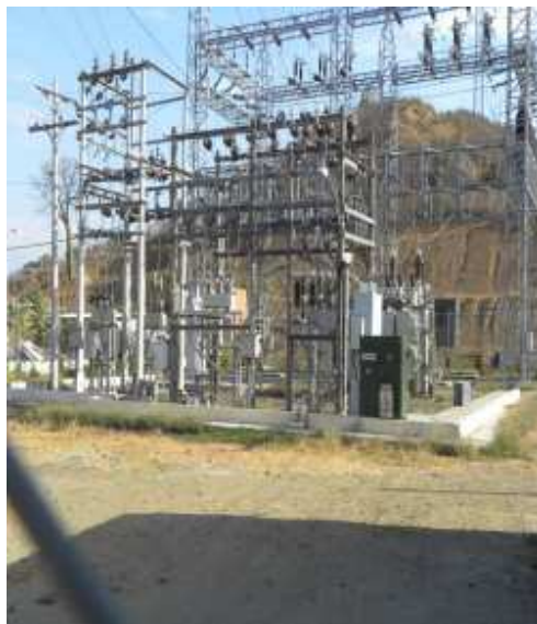
Figura 159. Bahía de 13,8 KV
