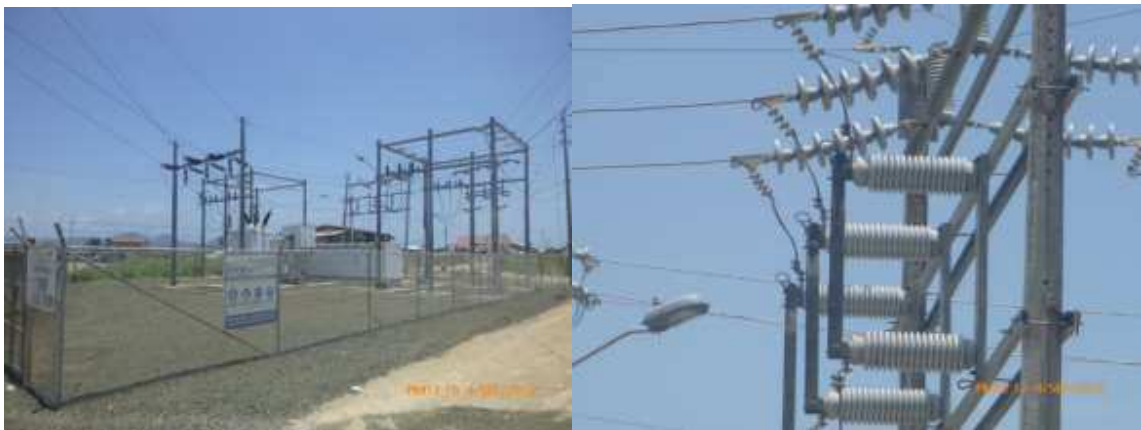
Figura 261. Subestación San Vicente
