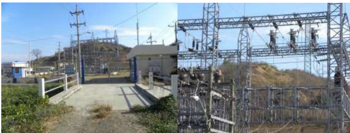
Figura 154. Subestación Río de Oro
