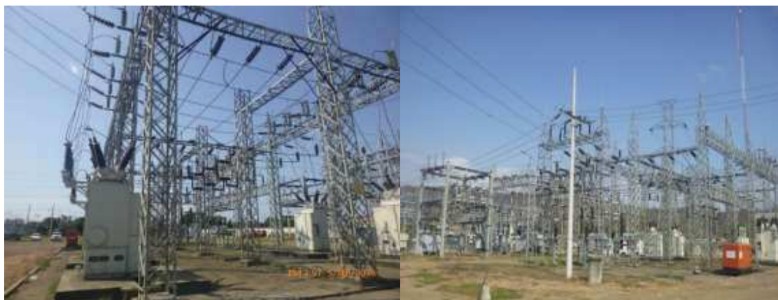
Figura 109. Subestación de Portoviejo 1
