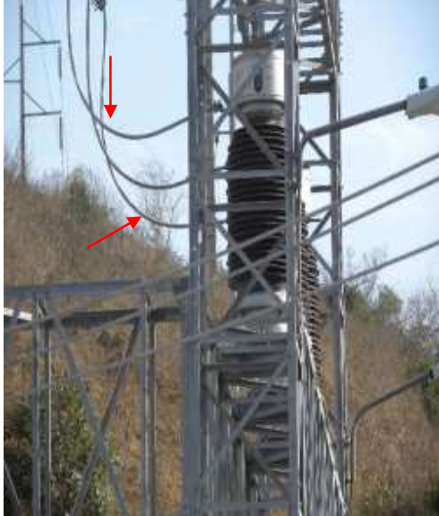
Figura 157. Conductor alimenta los TP.
