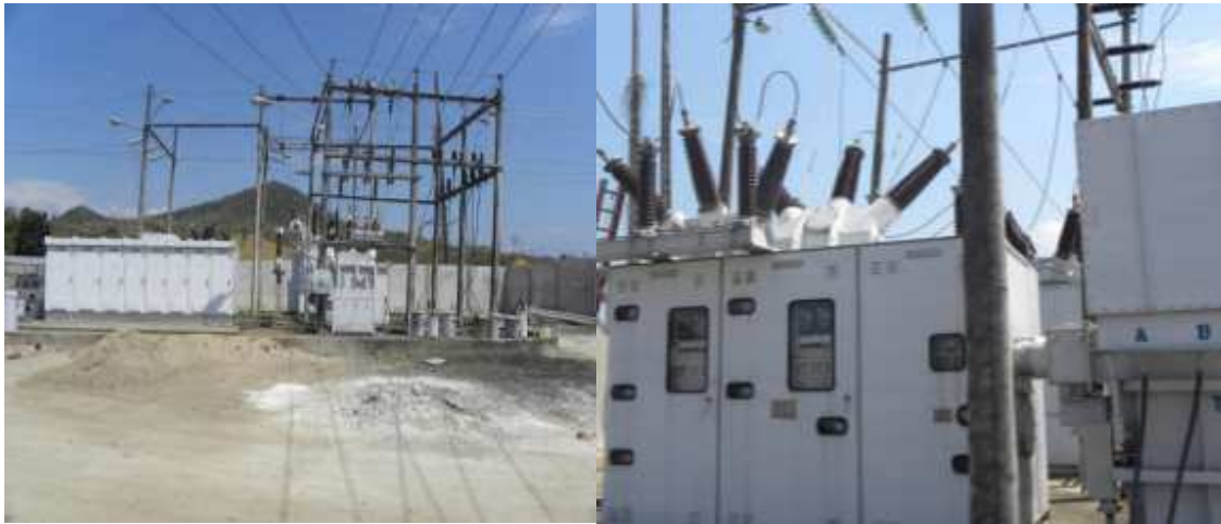
Figura 46. Subestación de Lodana
