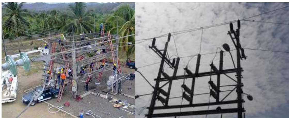
Figura 100. Subestación de Playa Prieta
