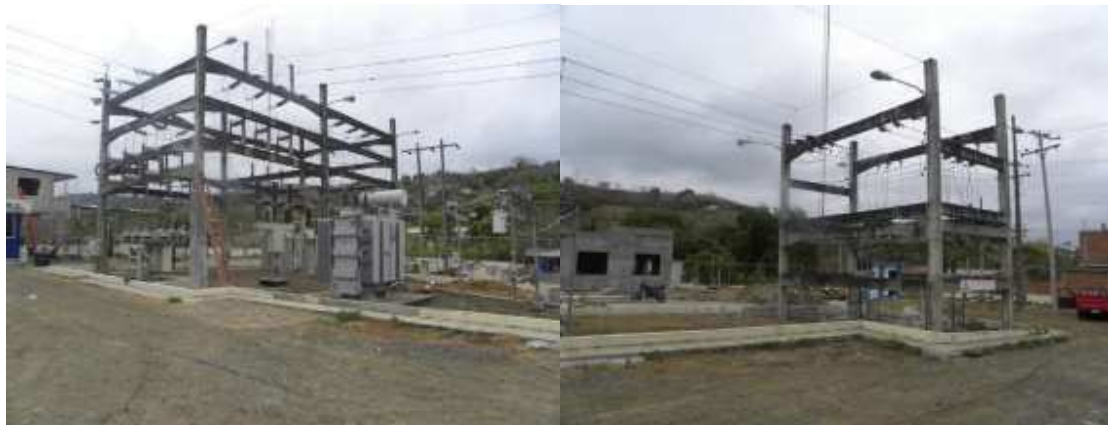
Figura 37. Subestación de Jipijapa
