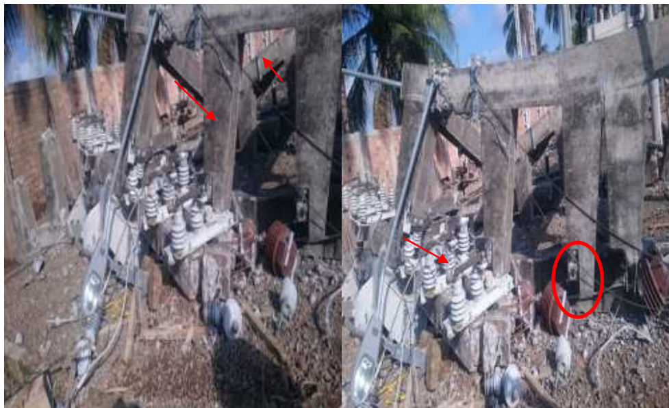
Figura 101. Bahía 13,8 KV colapsada Figura 102. Equipos averiados TC
