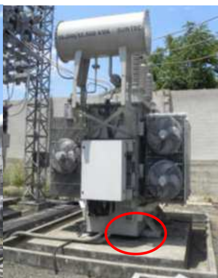
Figura 4. Base de transformador
