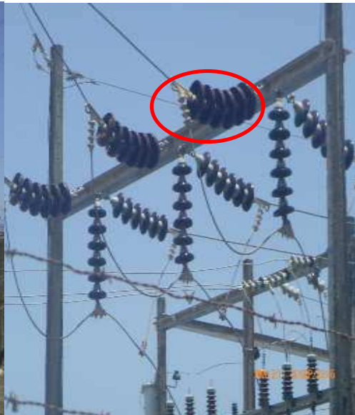
Figura 263. Aislador de suspensión 69 KV
