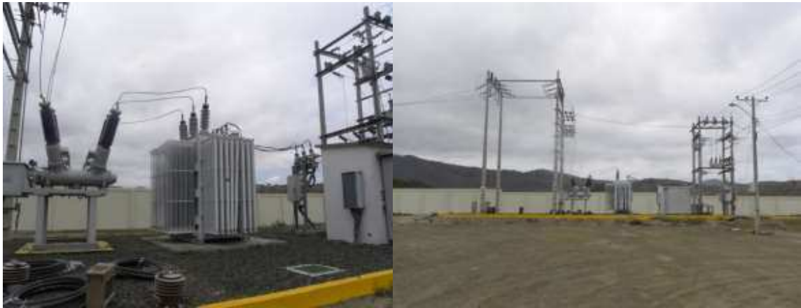
Figura 145. Subestación de Machalilla
