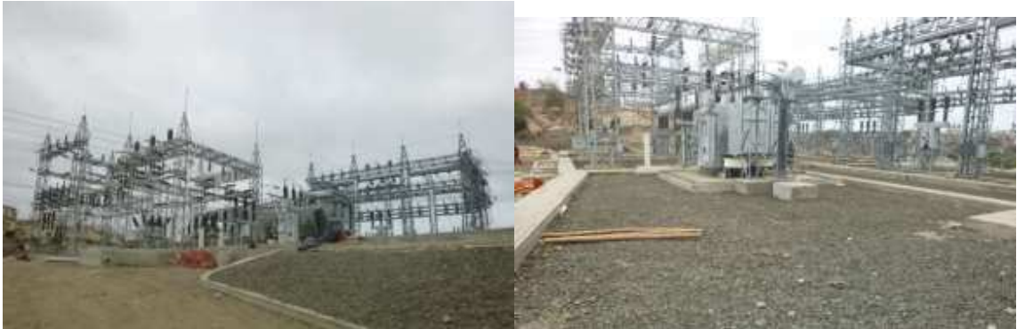
Figura 55. Subestación de Manta 1
