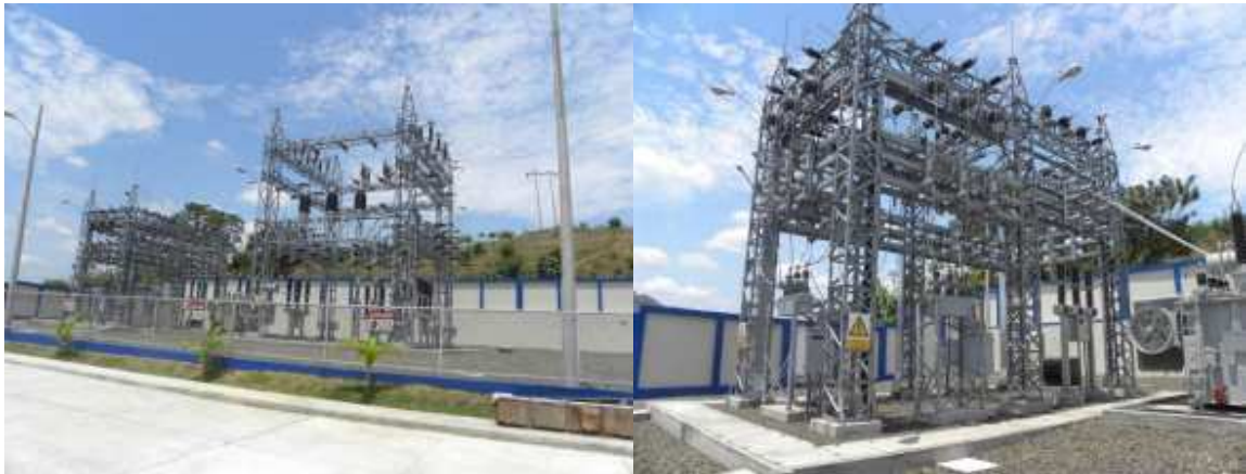
Figura 163. Subestación Santa Ana
