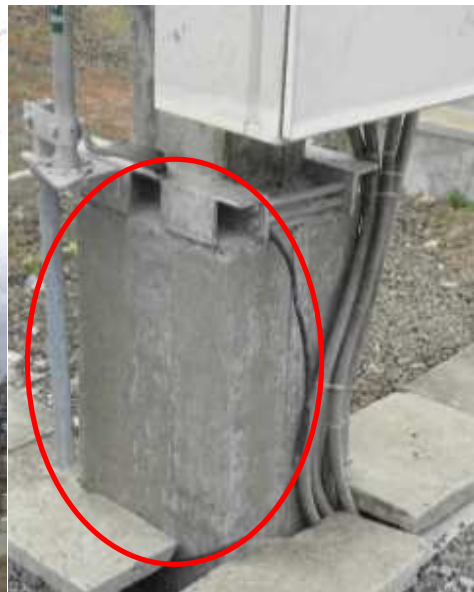
Figura 39. Reforzamiento de columna
