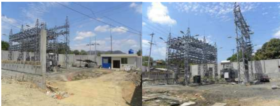
Figura 2. Subestación Barranco Colorado
