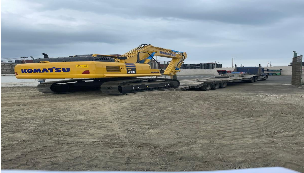
Ilustración 3: Descarga de grúas en el Patio 3 TPM
