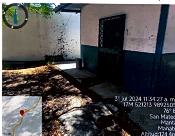
Figura 6. Estación de Bombeo Sauces
