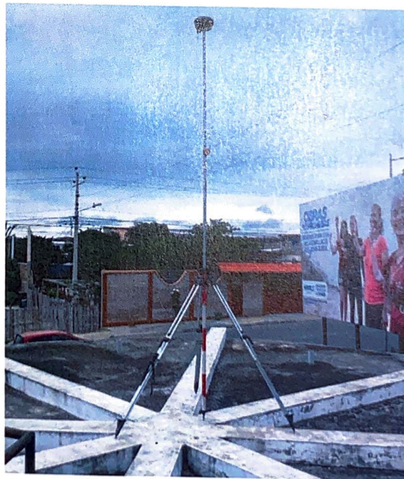
Anexo fotográfico 2. Inicio del levantamiento
