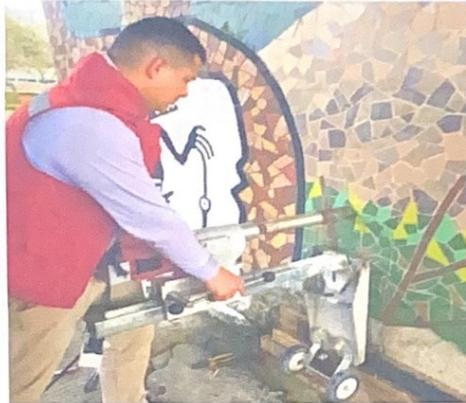
**Figura 13** Extracción de Núcleo en Paso a desnivel Tarquí.
