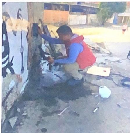
*Figura 39 Pachometría en pilas.*
