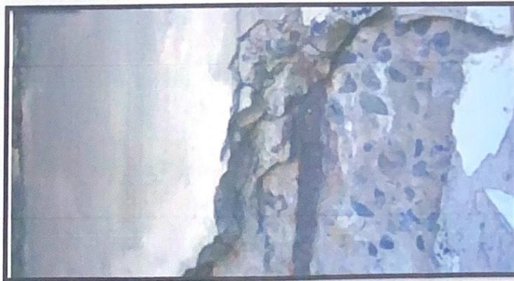
**Figura 6** Corrosión en Armaduras inducidas por carbonatación en estructuras de concreto reforzado.
