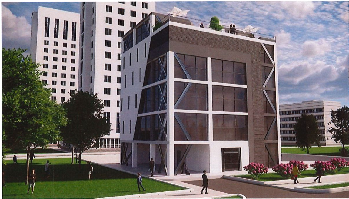
Figura 117. Vista 1 de render de la estructura del Acero A588 y del A36
