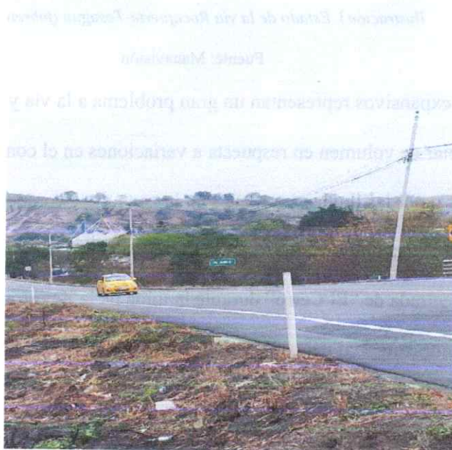
Ilustración5. Entrada del Junco (diciembre del 2024)
