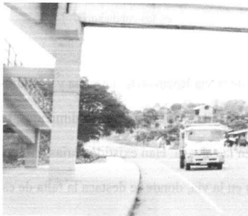
Ilustración 1. Vía Rocafuerte-Tosagua rehabilitada y en funcionamiento (año 2013)
