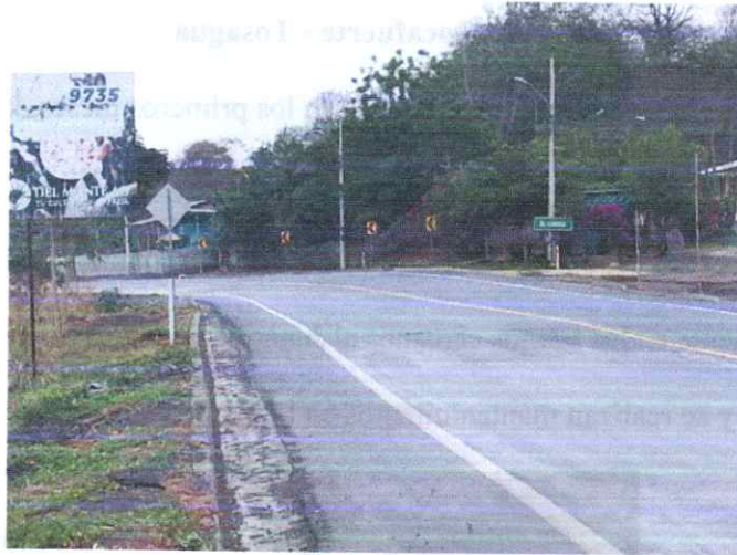
Ilustración4. Afectación en la entrada del Cerro (diciembre del 2024)
