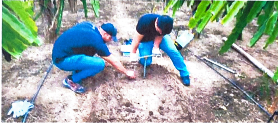
Figura 29. Perforación a estrato de 30 – 40 cm
