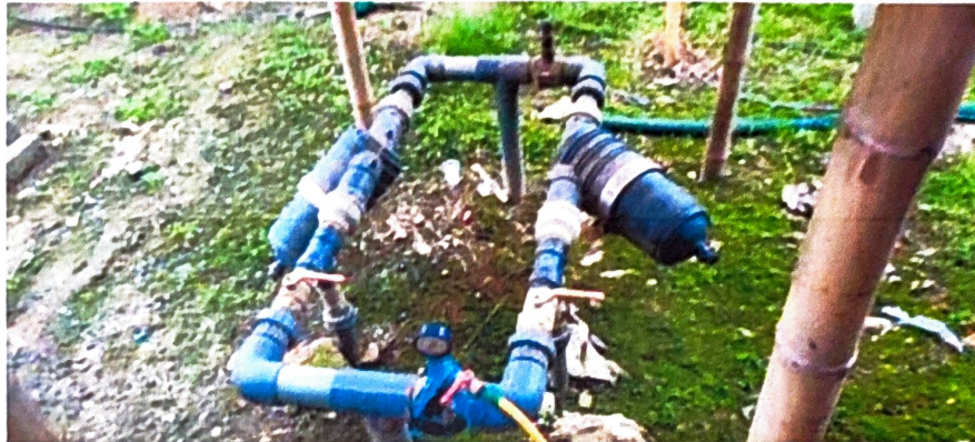
Figura 22. Cabezal de riego localizado.
