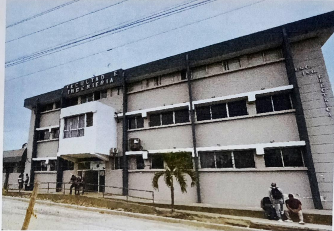
Figura 21. Edificio carrera de Electricidad
