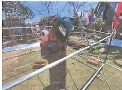
Ilustración 7 Construcción del galpón
