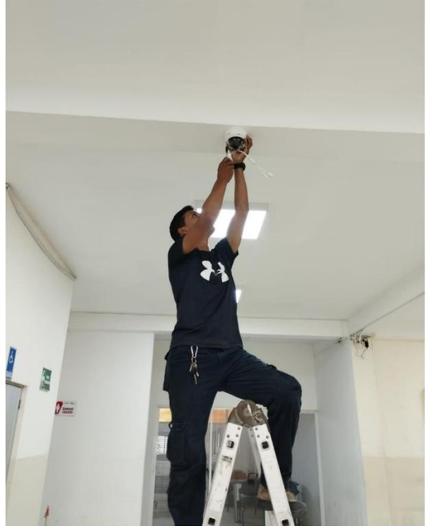
Ilustración 30. Integración de cámaras conectadas en facultad a NVR grabador
