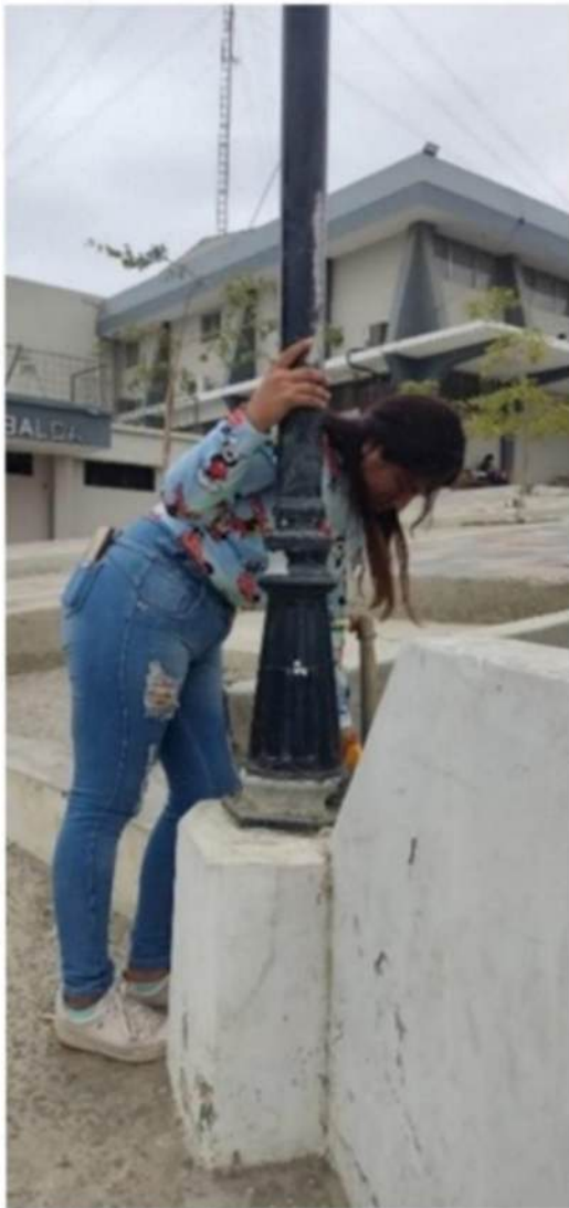
Ilustración 92. Instalación del riego
