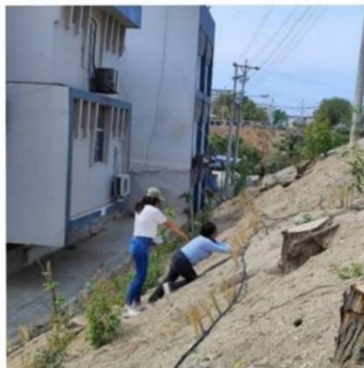
Ilustración 93. Instalación del riego y detalles del riego
