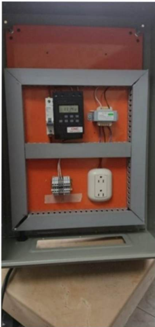
Ilustración 94. Tablero y servidor del riego
