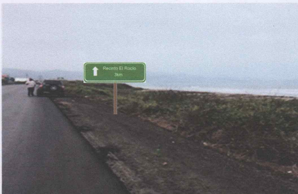
Figura 11. Montaje de señalética
