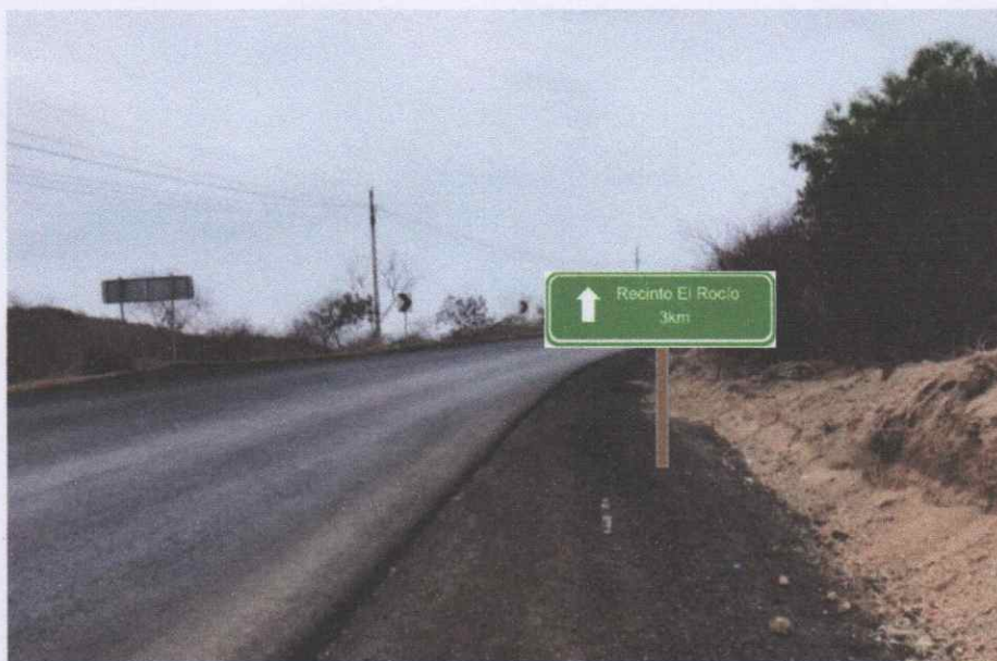
Figura 7. Montaje de señalética
