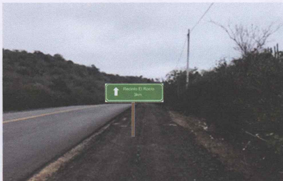
Figura 13. Montaje de señalética
