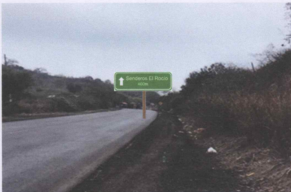
Figura 9. Montaje de señalética
