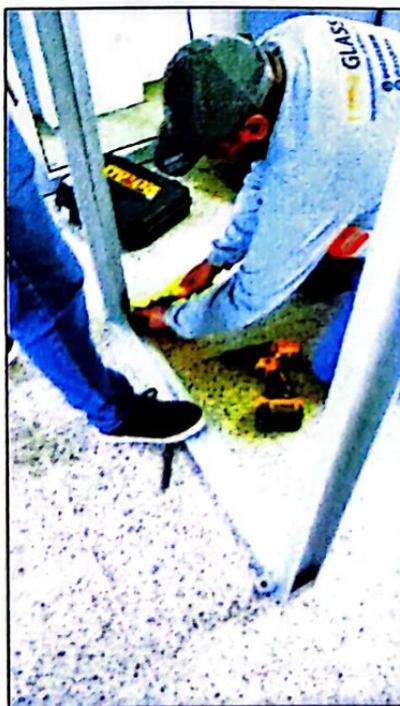
Proceso de corte y ajuste del marco metálico para la instalación de la nueva puerta
