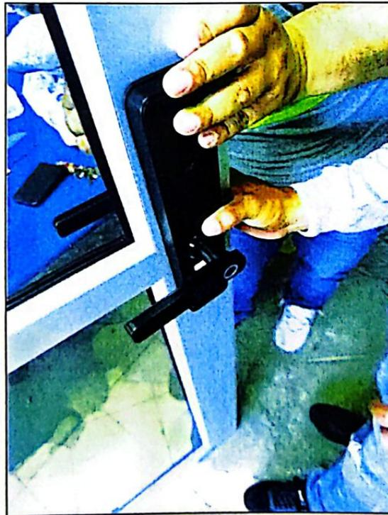
Colocación de la cerradura en la puerta. La chapa debe quedar alineada y fijada de manera correcta antes de proceder con el ajuste final
