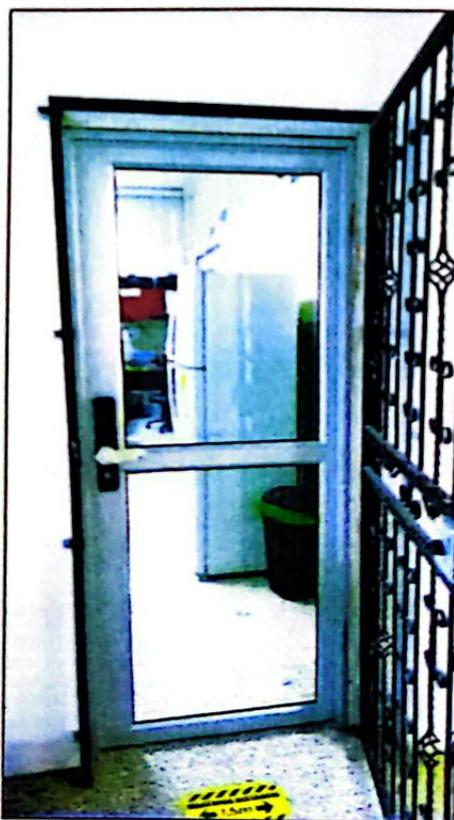
Instalación completa de la cerradura en la puerta. La chapa y el mecanismo están correctamente alineados y fijados, garantizando su funcionamiento adecuado.
