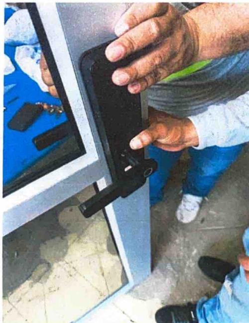
**Figura No. 12. Colocado la cerradura inteligente en la puerta**
