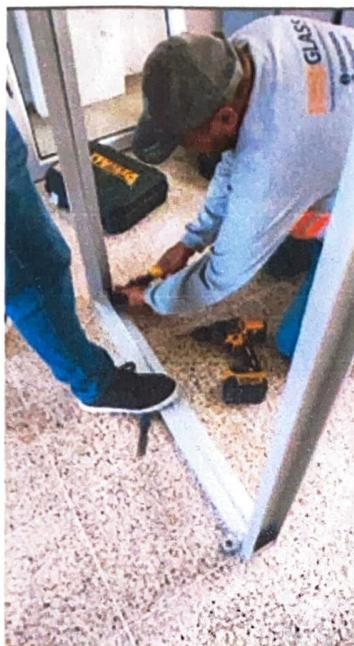
Proceso de corte y ajuste del marco metálico para la instalación de la nueva puerta
