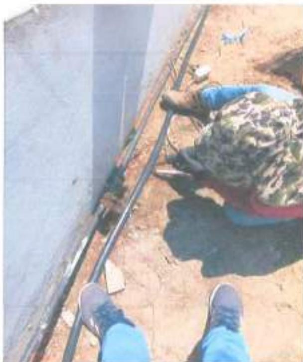
*Nota. Instalación de la tubería de 1" pulgada y manguera de 16 mm.*
