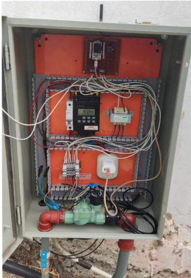
*Ilustración 72. Implementación y ensamblar componentes del sistema 3*
