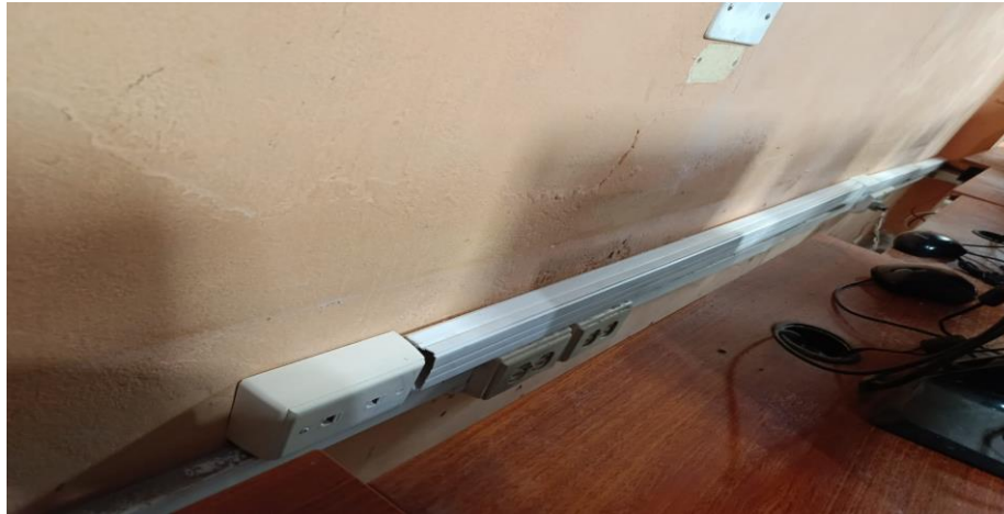
Ilustración 13 Instalacion de puntos de red
