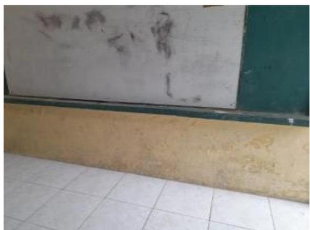
*Ilustración 15 Instalaciones con humedad*
