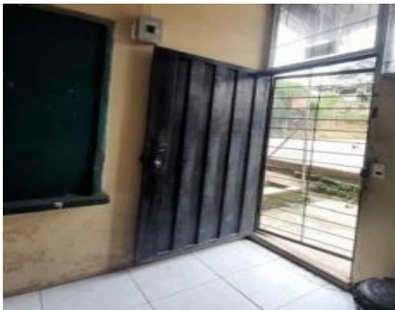
*Ilustración 14 Muro para evitar el ingreso de agua*
