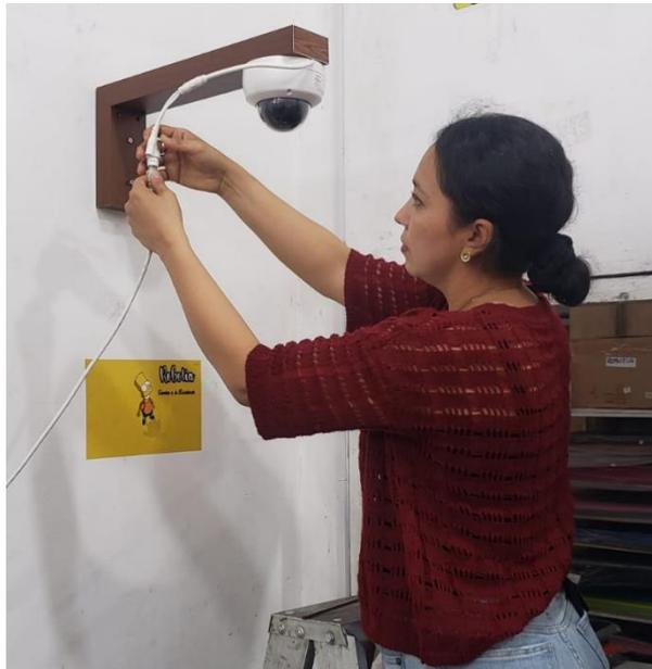
*Ilustración 23: Conexión de internet y energía de la primera cámara*
