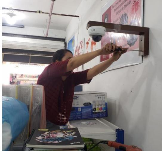
*Ilustración 11: Instalación de la primera cámara*
