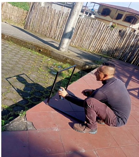
Ilustración 3 Elaboración de la estructura para el módulo
