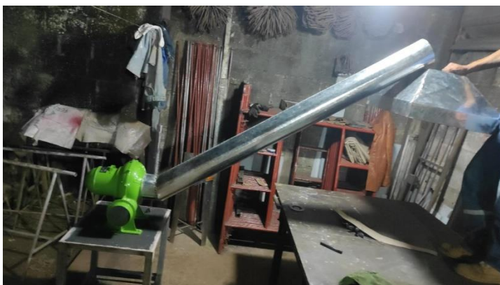
IMAGEN 2 Tubería y Soporte de Extracción
