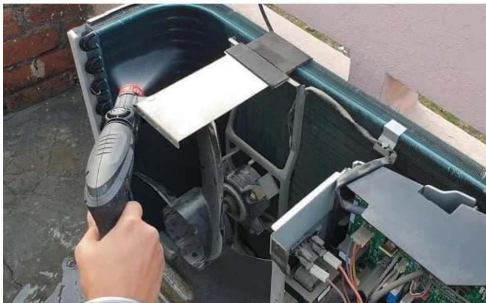
Ilustración 5 Como limpiar el aire acondicionado (Refri-climas, 2023).
