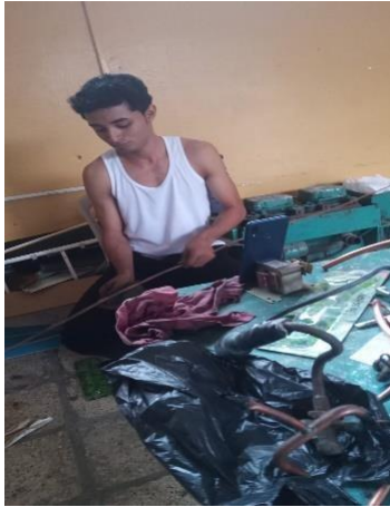
Ilustración 40 Limpieza, limado de tubería cobre
