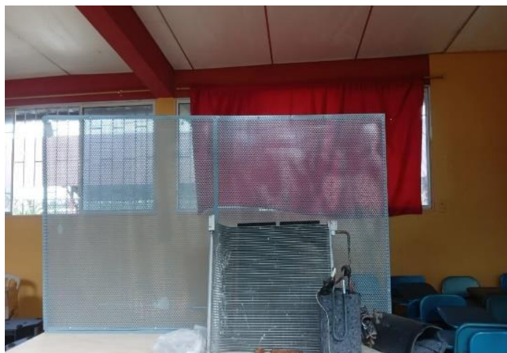
Ilustración 35 Desmontaje unidad externa condensador
