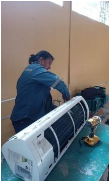
Ilustración 34 Desmontaje unidad evaporadora
