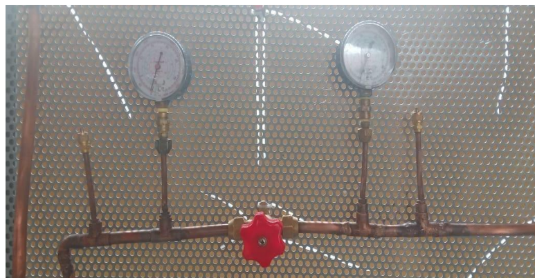
Ilustración 41 Instalación en la malla perforada
