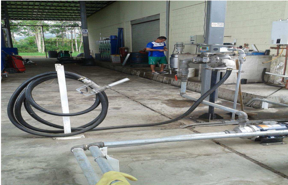
Foto N° 5: Mangueras de succión y descarga de biocombustibles.
