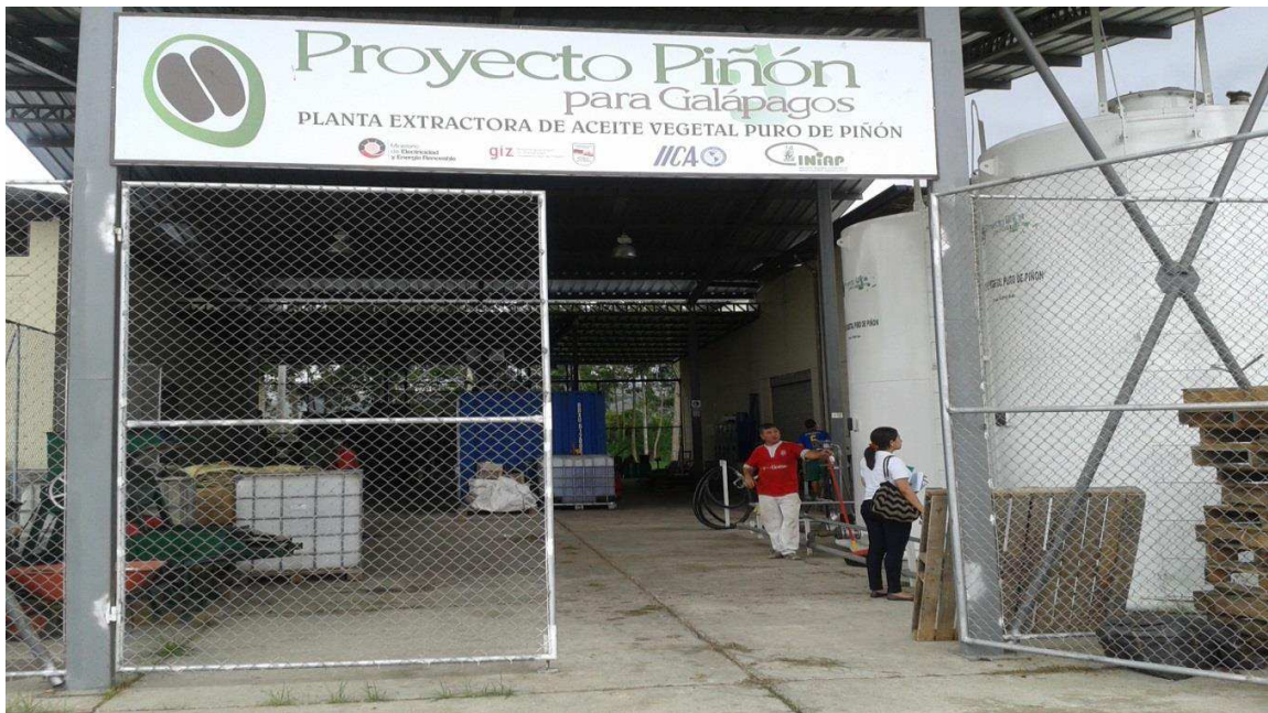
Foto N° 4: Proyecto Piñón Galápagos INIAP. Planta Extractora de Aceite Vegetal Puro de Piñón.
