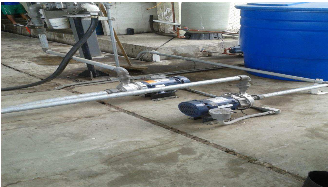
Foto N° 6: Bombas de succión.
