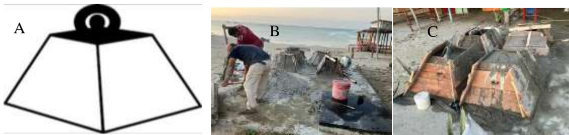
**Figura 4.** A. Modelo de lastre piramidal utilizado para el sistema de fondeo de las linternas chinas. B. Proceso de preparación del concreto para el relleno de lastres. C. Relleno de los lastres luego de colocar internamente las varillas de acero monel.
