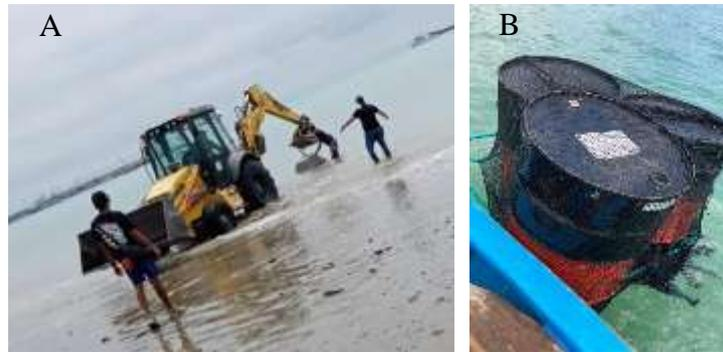
**Figura 5.** A. Transporte de lastres hacia el perfil costero en marea baja. B. Cilindros de 200L.
